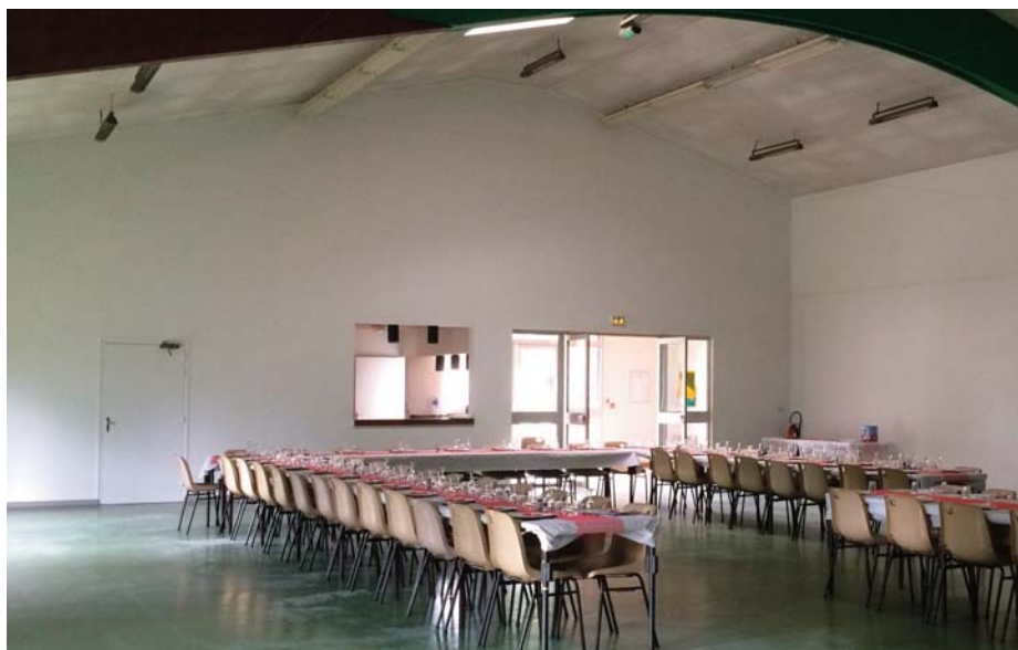
A peine les travaux terminés la salle était déjà utilisée pour un repas d'anniversaire.
