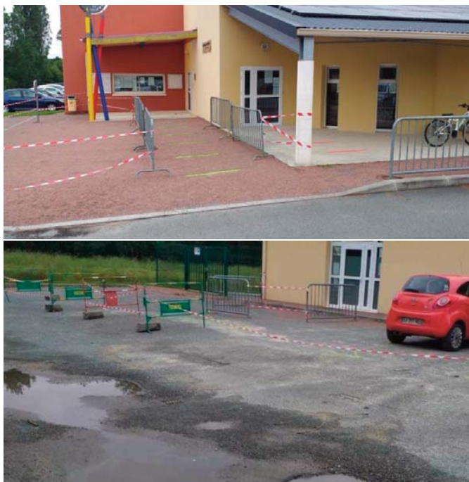
Les entrées de l'école ont dû être modifiées et balisées.
